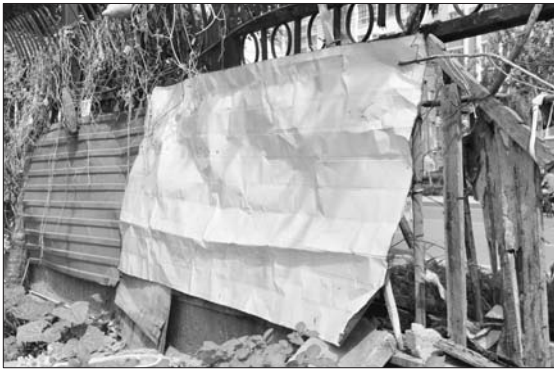
华滨嘉园小区北边坏掉的栅栏被物业公司工作人员用铁板补上。
