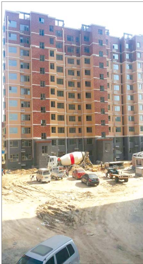
▲县城一项目工地正紧张施工。记者 杨擎 摄
