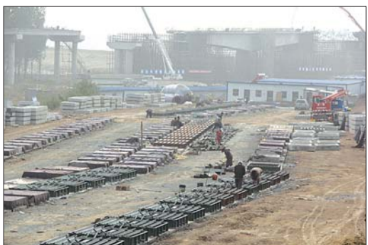
建设中的八里湾船闸。
