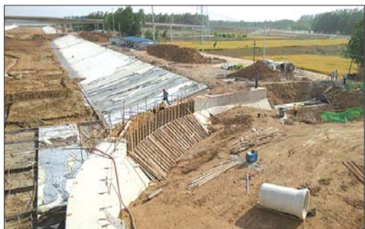
船闸下游辅导航墙。
