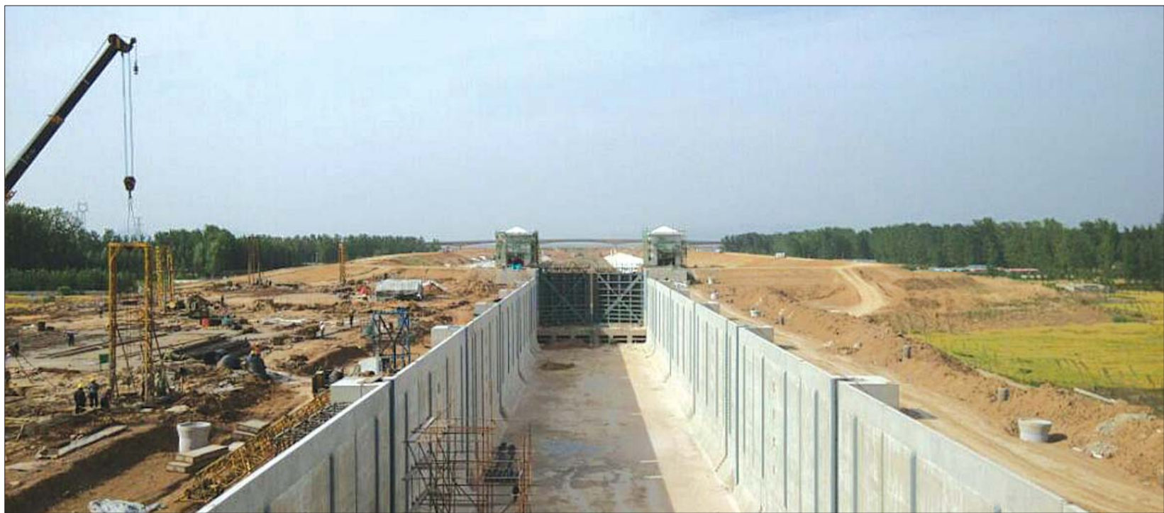
建设中的八里湾船闸主体。
