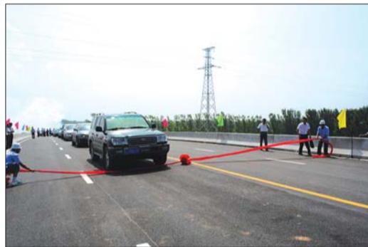
2013年7月，八里湾公路桥顺利通车。
