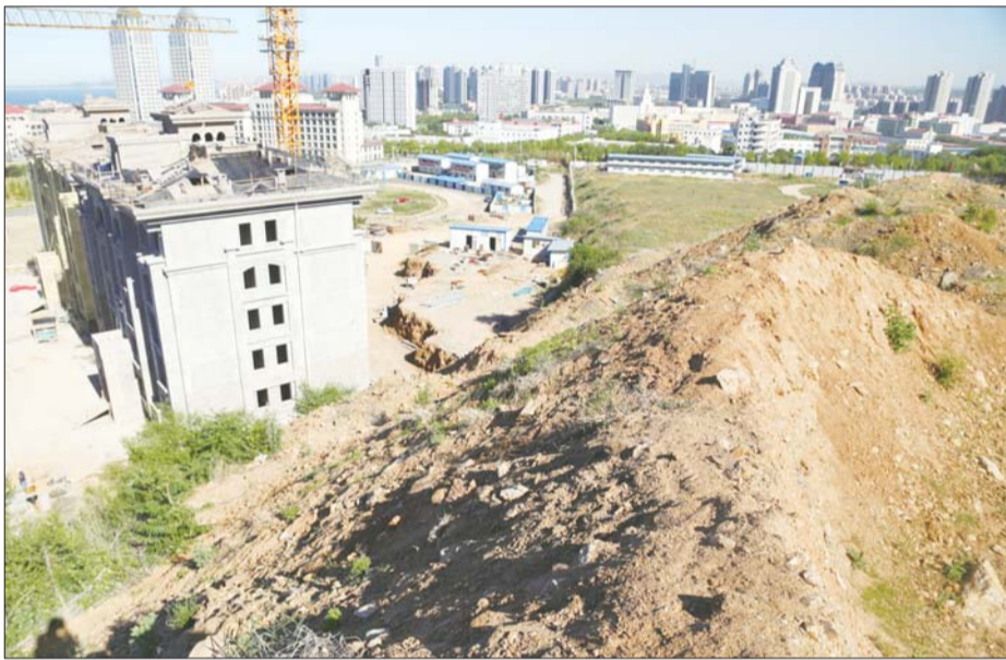
工商学院西侧与凤凰山东麓交界处,建筑渣土直接堆进了校园。 本报记者 韩逸 摄
