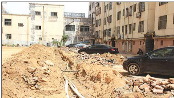
望岳C区楼与楼之间都被挖开进行管网改造。本报见习记者 胡阳 摄
