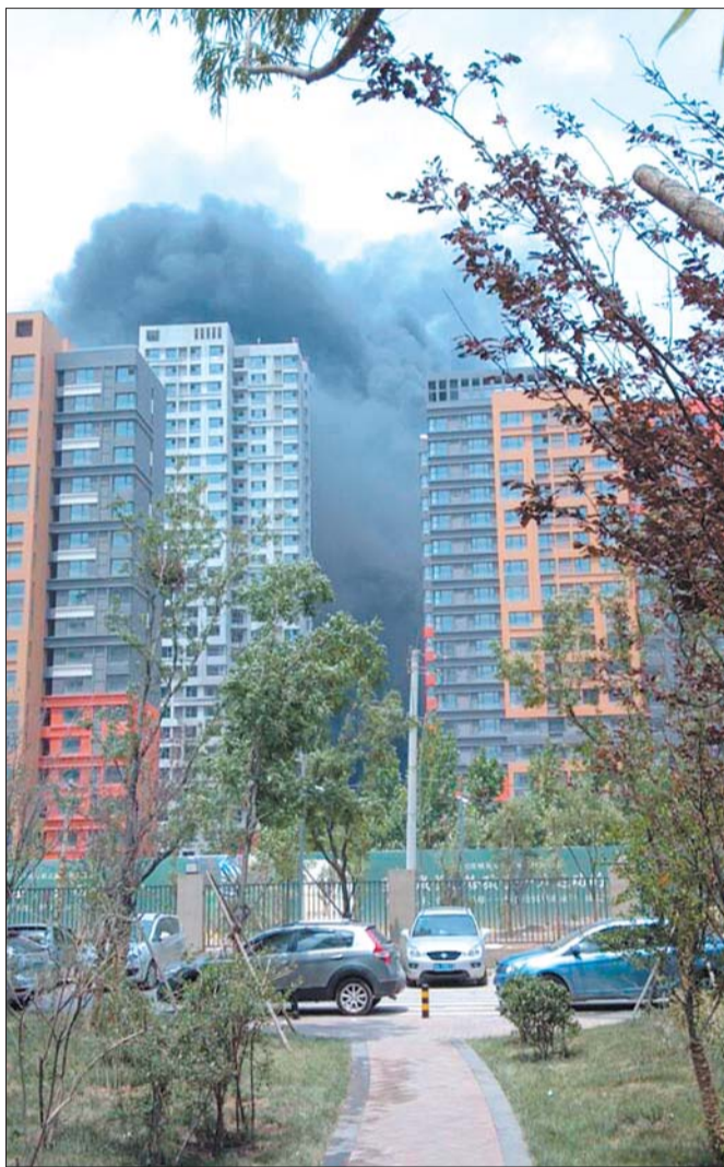
万象新天工地火灾现场。 网友供图
