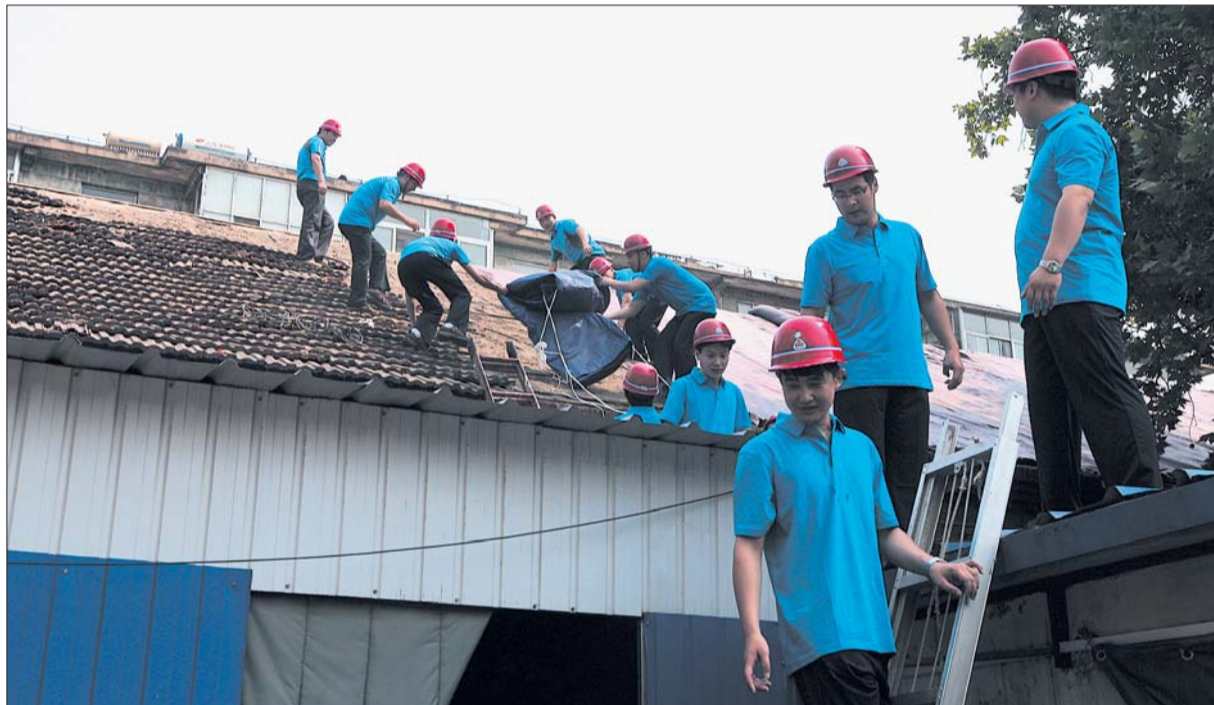
6日上午,天桥区住房保障和房产管理局的防汛抢险突击队员在工人新村南村中街23号进行了一次防汛实战演练,对汛期老旧房屋出现漏雨倒塌等危险情况进行处理。
