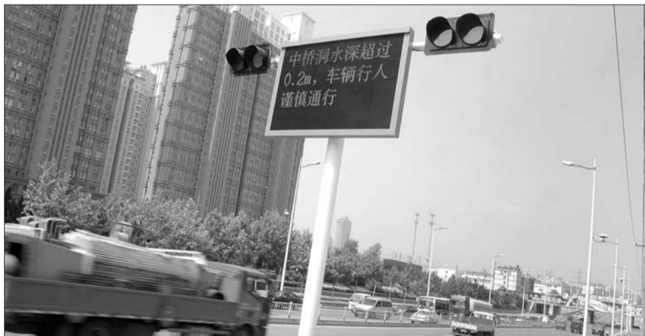
市区立交桥下安装积水警示系统,提醒过往车辆注意。本报记者 李泊静 摄
