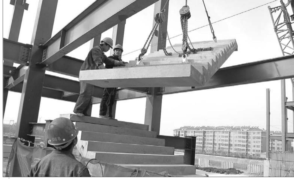
试点项目施工现场,工人正在安装预装楼梯。整个试点项目万余平米的建筑体量,都是由这样的预装部件拼接而成。
