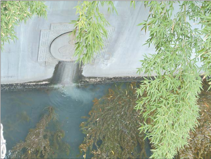
从思敏桥上近距离看排污口,污水已经腐蚀了水泥岸壁。 见习记者 王红星 摄
