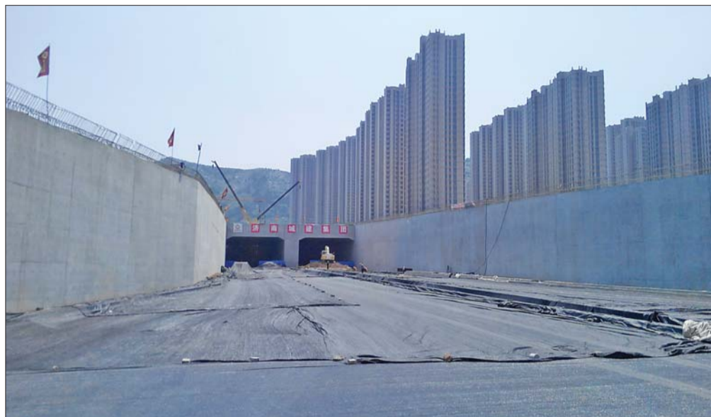
◀文庄公租房附近地下即将出现济南市最长隧道,图为隧道西侧入口。 见习记者 王皇 摄
