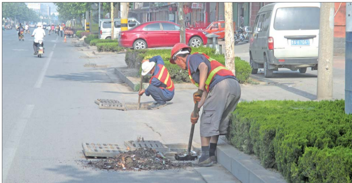
工人在掀开井算子清理淤泥。 本报记者 梁越 摄
