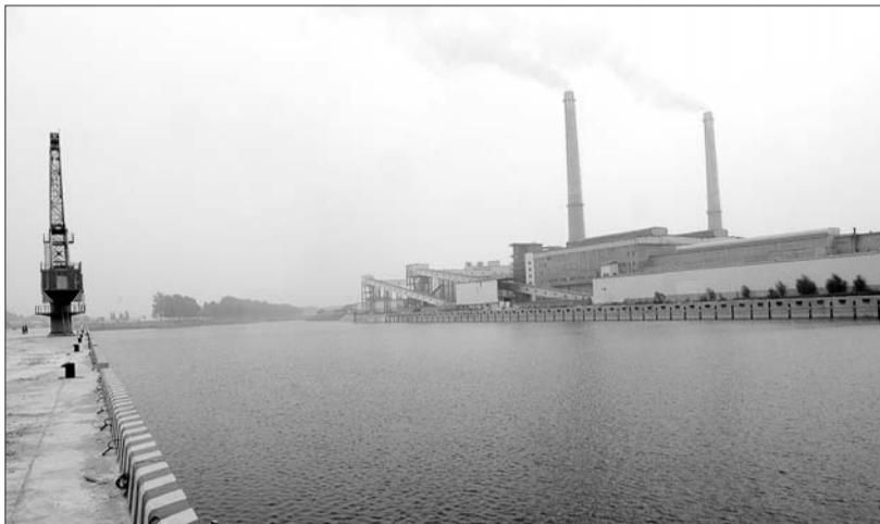
建设中的巨野港。
