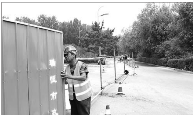
施工人员正在设置围挡。本报记者 李玉涛 摄
