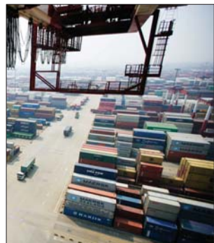
位于青岛西海岸新区的青岛港外贸集装箱码头,集装箱堆场堆积的集装箱。
