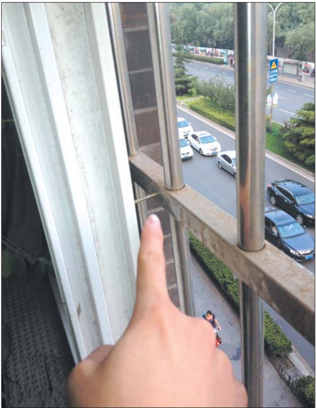
维修工人用钉子对高先生家的窗户进行了加固。
