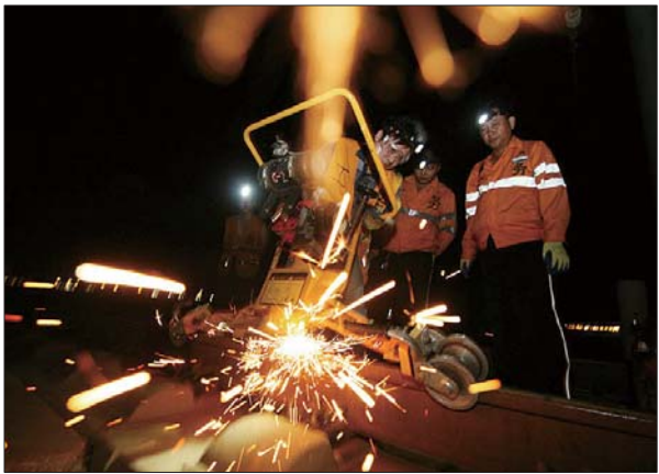
济南西工务段作业人员对道岔鱼鳞纹进行技术攻关。 通讯员 崔俊杰 摄
