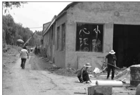
老年公寓正在施工。本报见习记者 于伟 摄
