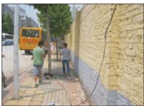
四中院墙外电缆线散落。 本报记者 王瑞超 摄
