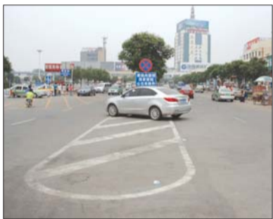
设置分道标线,禁止停车、越线。 本报记者 曹剑 摄
