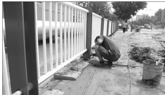
3日,事发水沟安装上了新栏杆。
