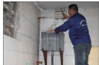
维修人员对居民楼公共水箱进行维修。
