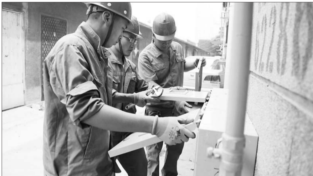
施工现场。本报记者 张冬梅 本报通讯员 张军 摄
