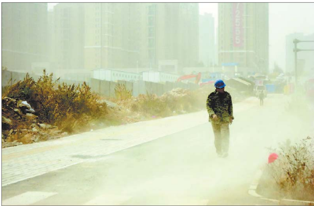
在济南一些防护措施不到位的工地周边,扬尘污染严重。资料片
