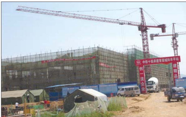
工人搭起帐篷日夜开工建设。 本报记者 孙健 摄
