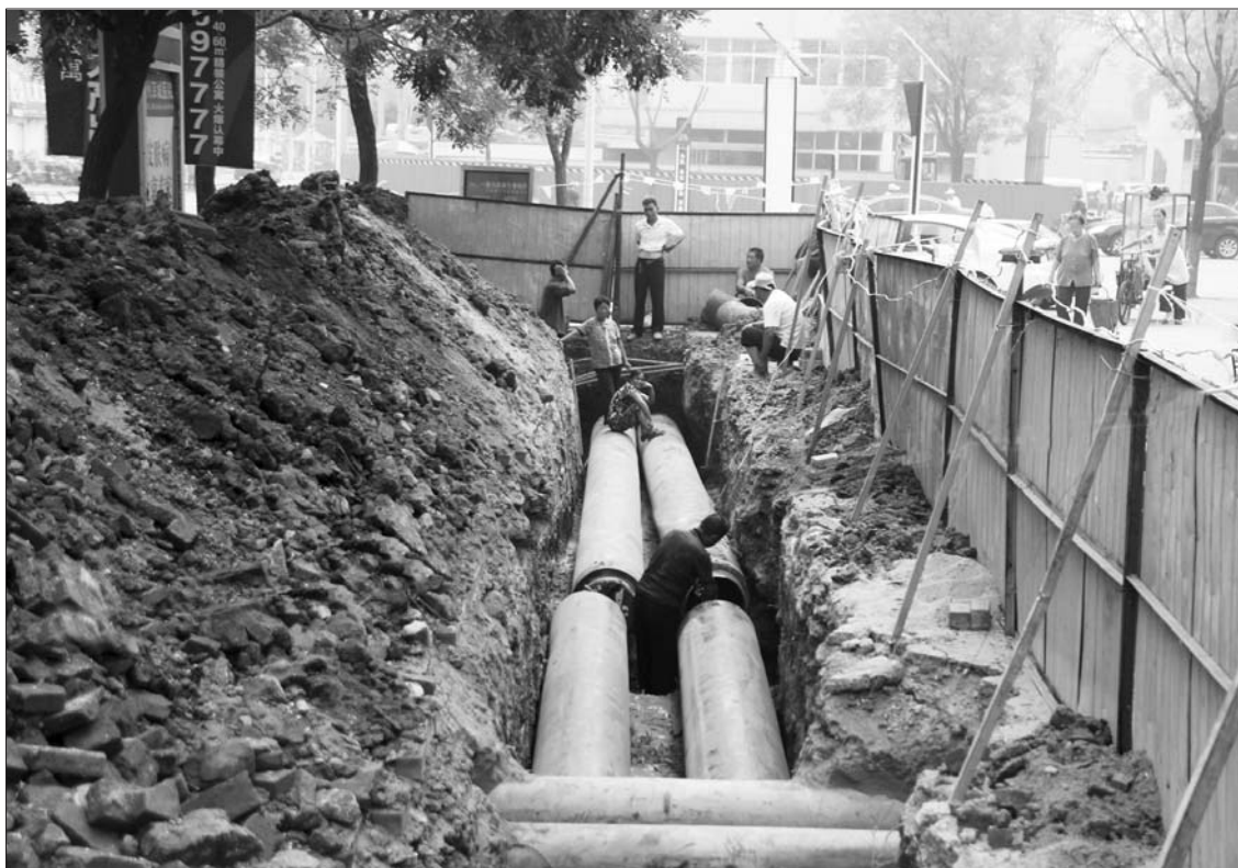
7月7日,文化路上施工人员冒着酷暑铺设新供暖管网。 本报记者 王小会 摄
