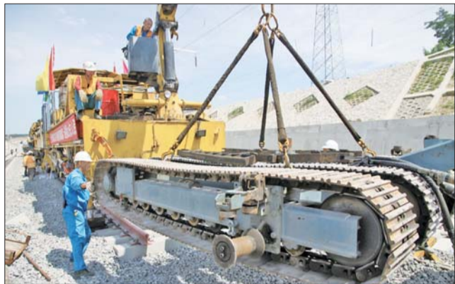
▲施工人员正在移动履带。见习记者 丛子茗 摄
