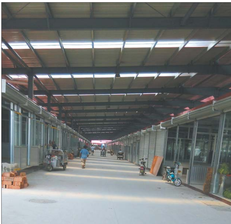
不少商家正在装修新建好的摊位。
