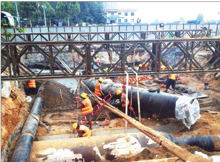
凤凰路经十东路路口管线施工。项目部供图
