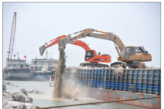
正在紧张施工的防波堤工程。
