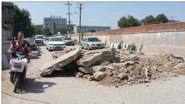
福山区蒲湾街附近一条道路中段被挖了坑,只容得下行人和自行车通过。本报记者蒋大伟摄
