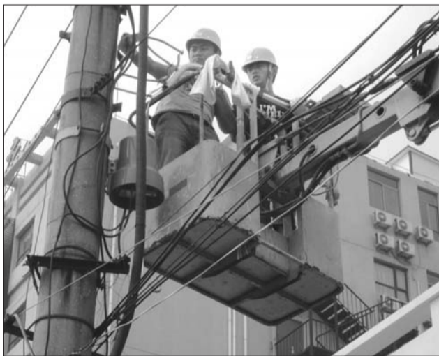
施工人员正在安装路灯。 本报记者 赵念东 摄
