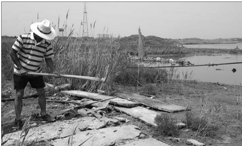
15日上午,工作人员正在清理传输线路上面的水泥保护层。 本报记者 刘伟 摄
