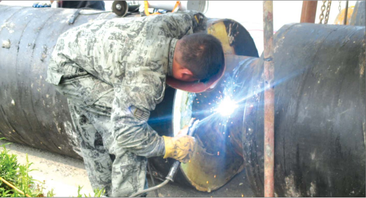
施工人员正冒着酷暑焊接蒸汽管道。 本报记者 梁越 摄
