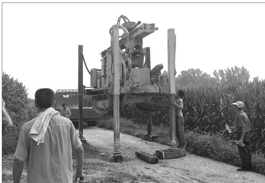
22日,省地矿工程勘察院打井队伍携钻井设备开进罗家堂施工现场。本报记者 张璐 摄
