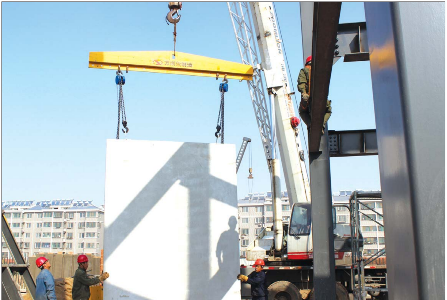
▲西客站片区安置三区小学产业化试点项目,工人正在吊装外墙板。(资料片) 本报记者 王媛 摄
