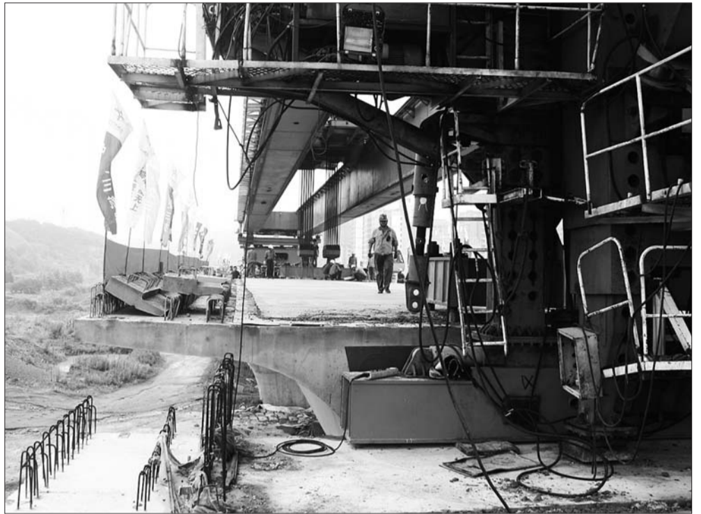
▲22日中午,中交三航局第三项目部施工人员见证桥梁的架设。记者 王帅 摄
