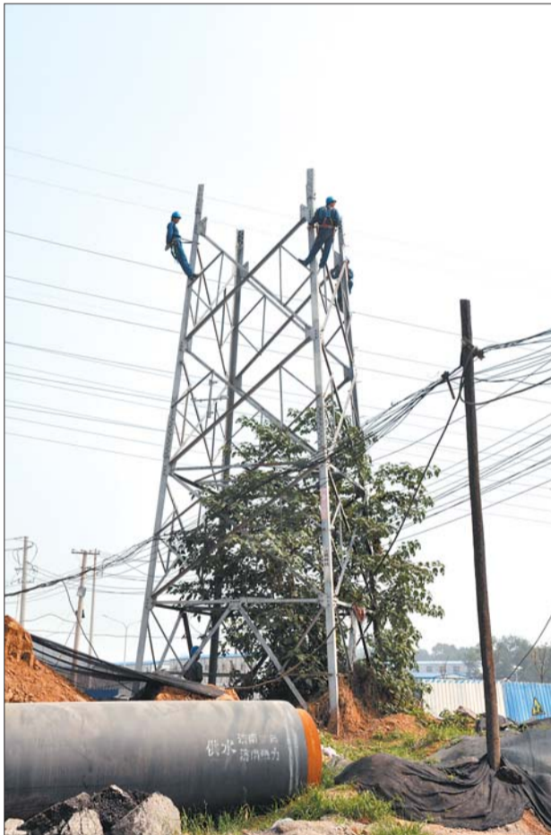
施工人员正在拆除高压铁塔。项目供图
