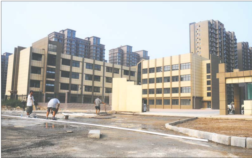
7月25日,施工人员正在打通八里庄小学门前的道路,为新学期学校投入使用做准备(资料图)。 本报记者 马志勇 摄
