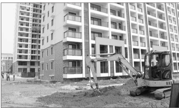
施工人员正在聊城路公租房小区内修路。本报记者 李玉涛 摄
