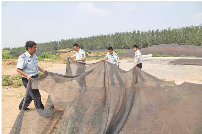
对工地露天渣土实施遮盖避免扬尘。
