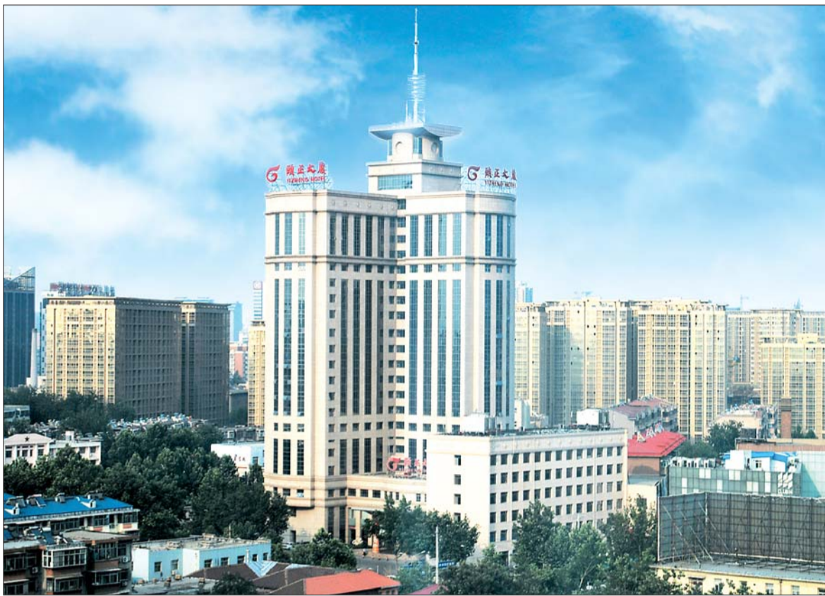
颐正大厦实景图
