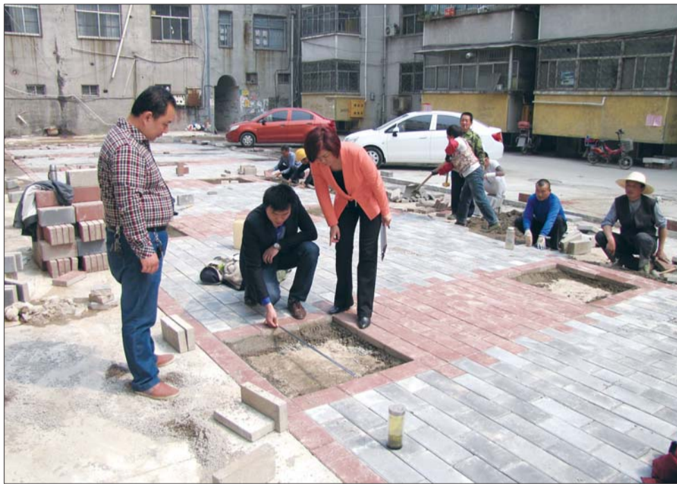
长安小区改造施工现场。(资料图)
