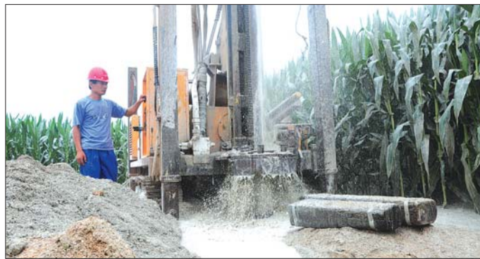
施工人员成功将钻机打入地下岩层,出水了。
