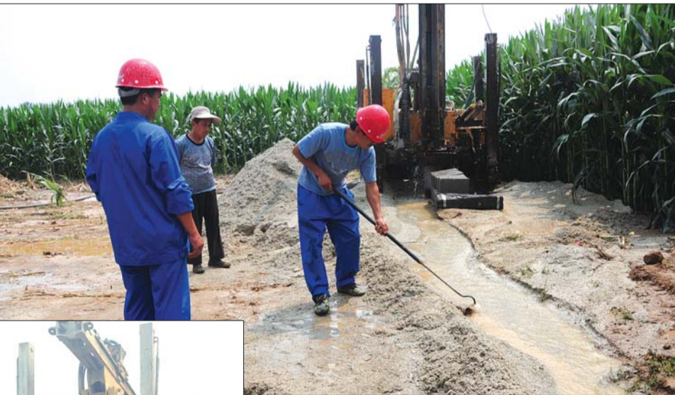
▲打井工人清理水道。
