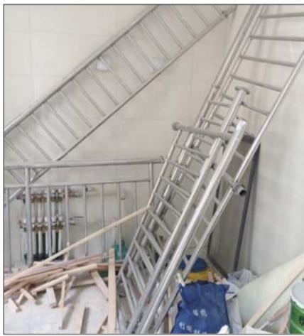
新房业主把开发商装的护栏全拆掉。
