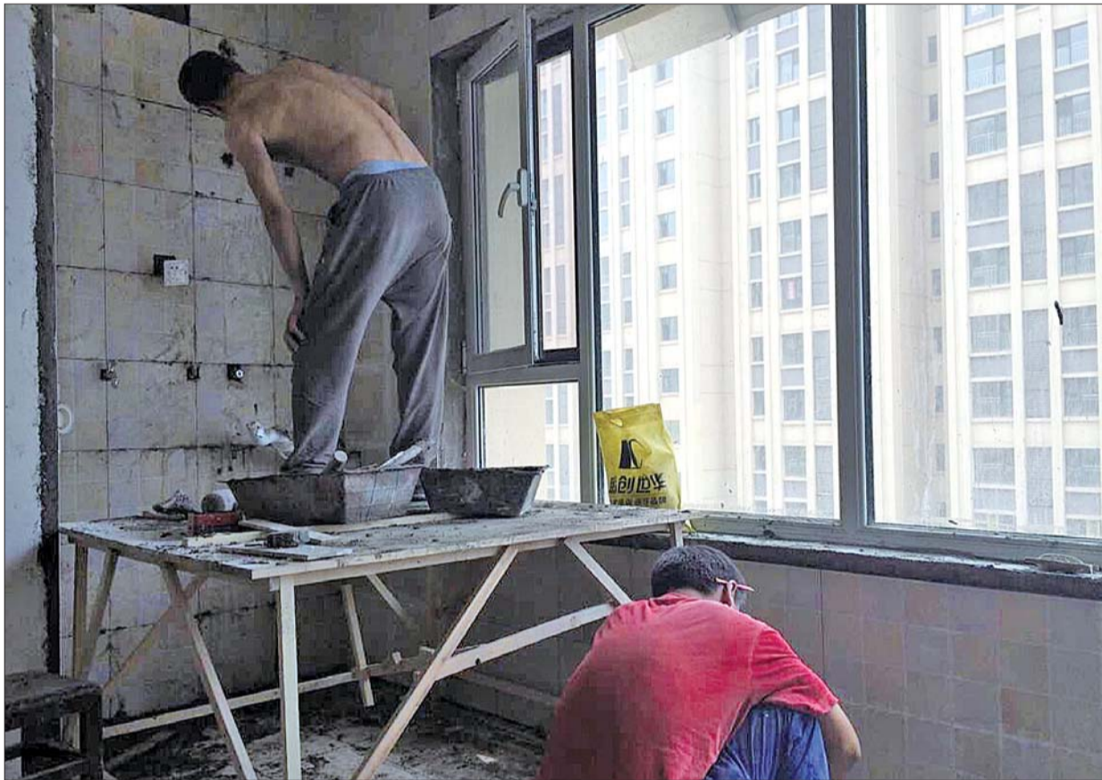
奥体西路,一新房业主装修砸掉阳台瓷砖重铺。
