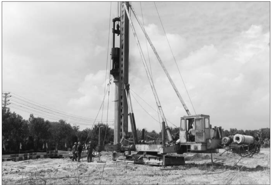
市固体废弃物转运中心项目施工现场。本报记者 郝运红 摄
