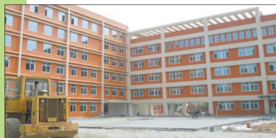
在伟东新都学校,工人们正在铺设教学楼前地面。 本报记者 刘雅菲 摄
