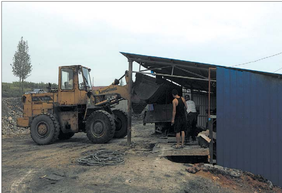
执法人员在非法石子厂的机械设备进行拆除。
