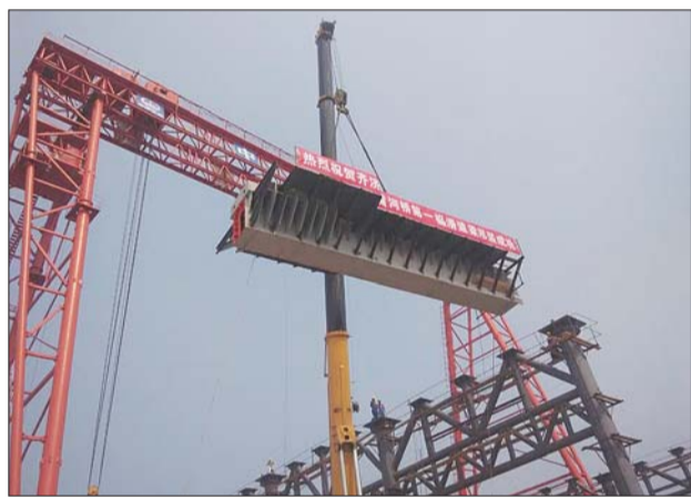
石济客专济南黄河公铁两用桥吊装第一榀滑道梁。见习记者 刘胜男 摄
