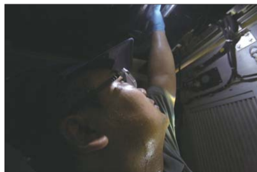
闷热的厢体内,作业人员精心检修每一个设备。
